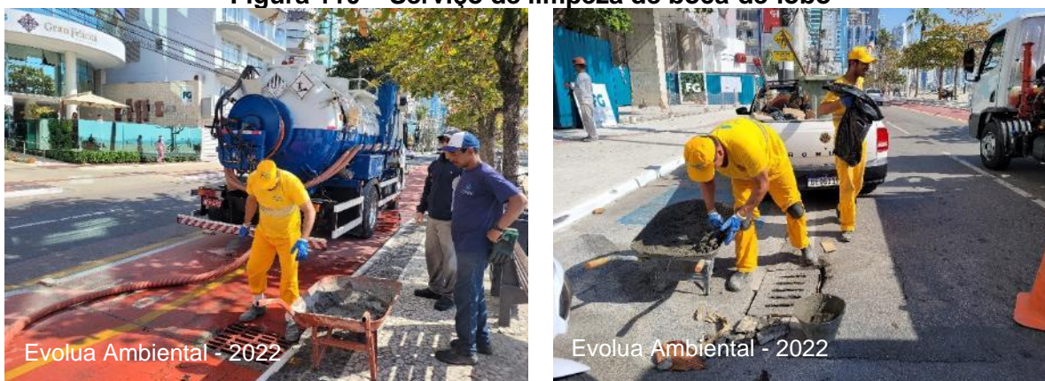
Figura 110 – Serviço de limpeza de boca-de-lobo
