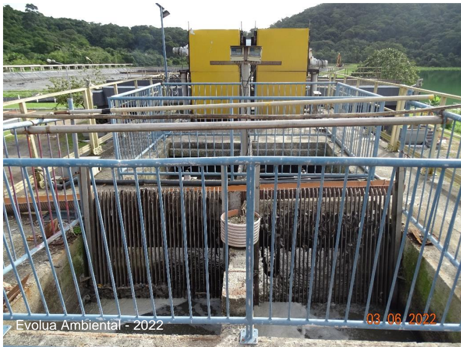
Figura 43 – Gradeamento.
