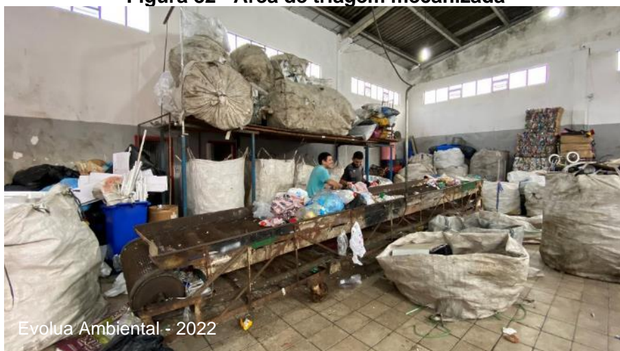
Figura 82 - Área de triagem mecanizada
