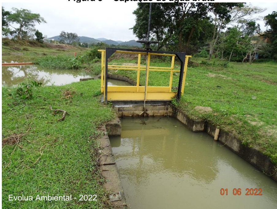
Figura 9 – Captação de água bruta
