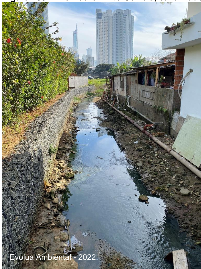
Figura 135 – Rio Pedro Pinto Correia, canalizado
