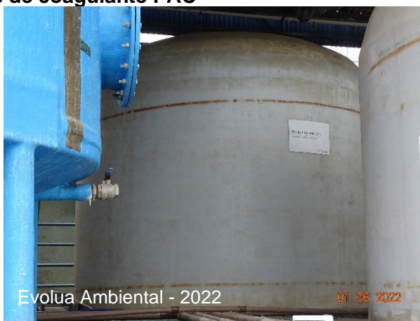
Figura 19 – Tanques de coagulante PAC
