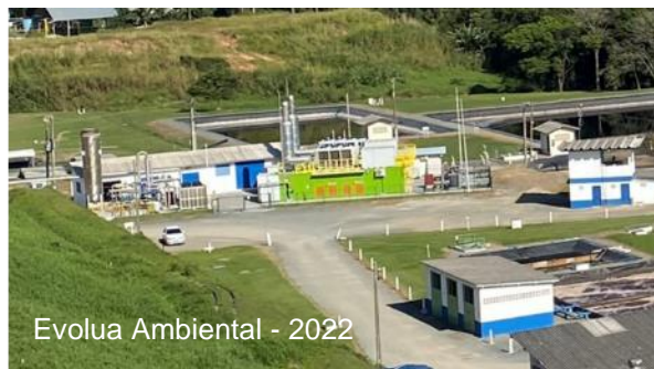
Figura 98 – Unidades de tratamento de efluentes líquidos e gasosos do aterro sanitário
