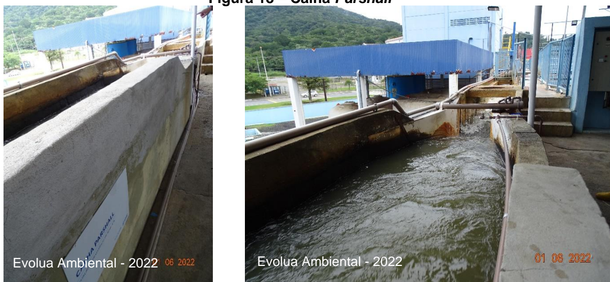
Figura 18 – Calha Parshall
