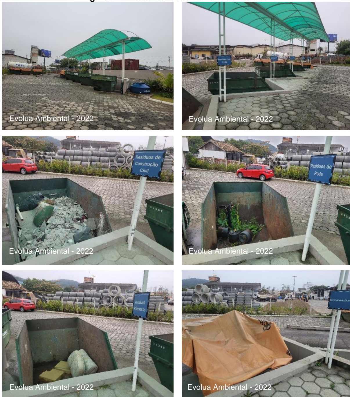
Figura 91 – Baias de recebimento dos resíduos
