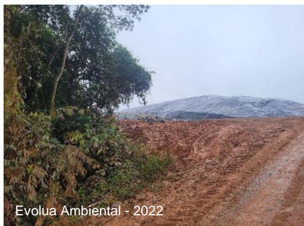
Figura 100 – Cobertura de maciço com lona de PEAD
