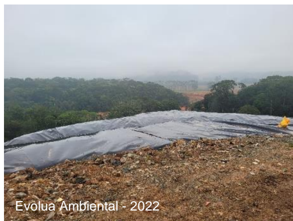
Figura 100 – Cobertura de maciço com lona de PEAD
