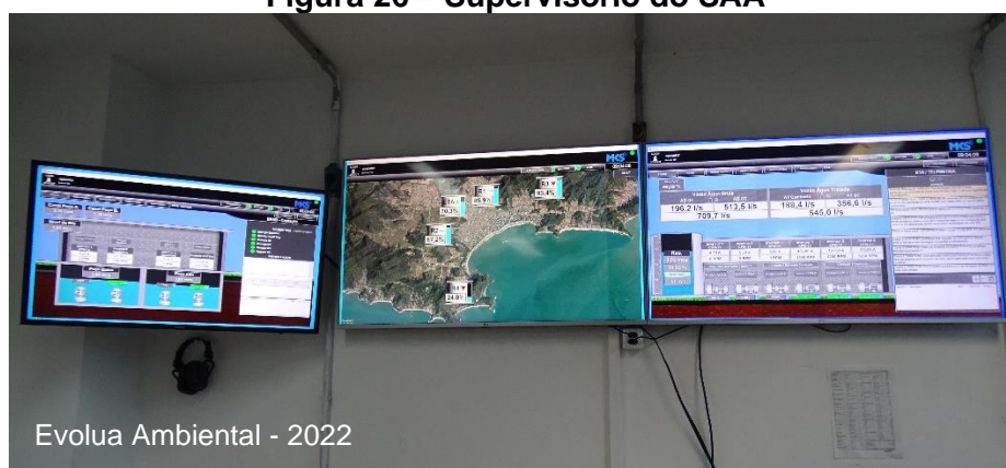
Figura 26 – Supervisório do SAA
