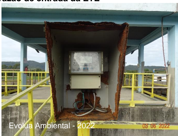
Figura 46 – Medidor de vazão de entrada da ETE
