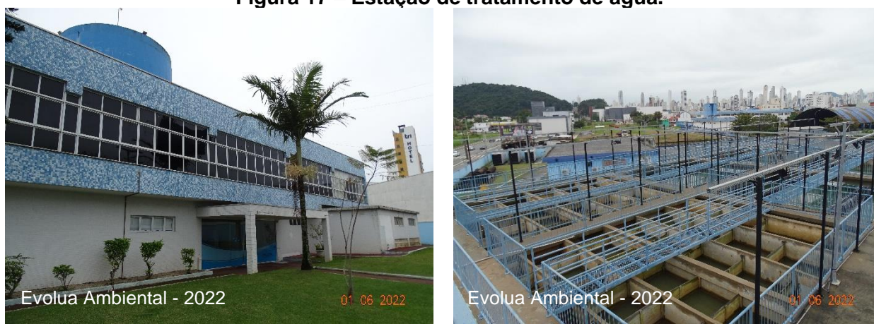
Figura 17 – Estação de tratamento de água.
