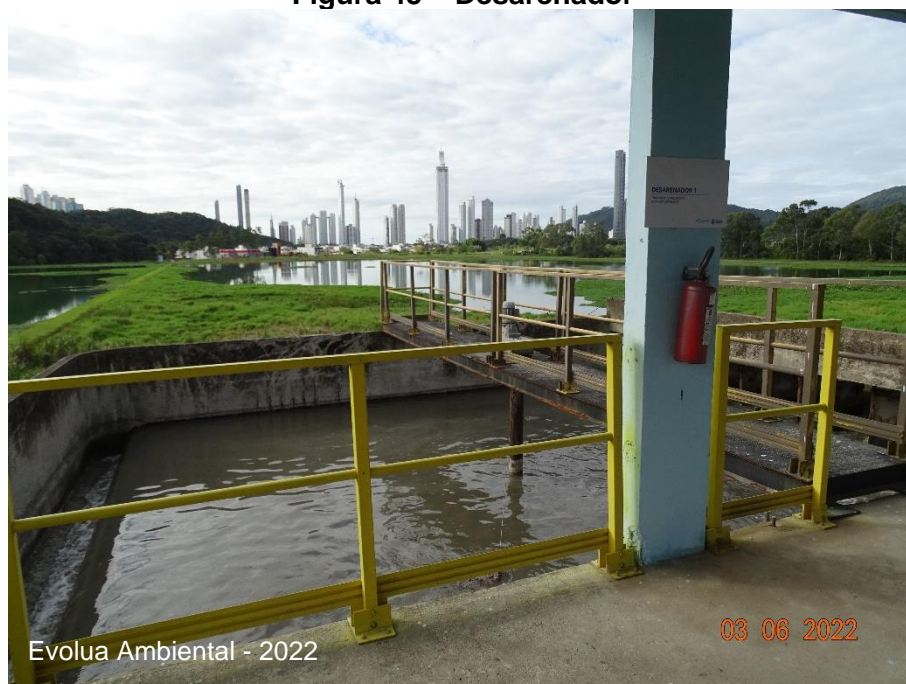
Figura 45 – Desarenador
