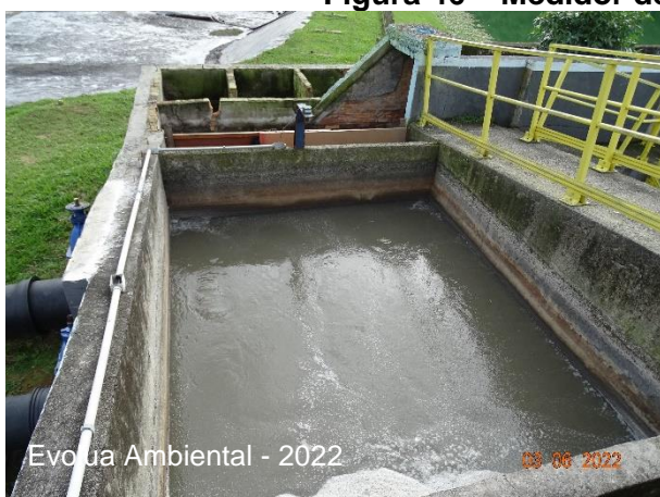
Figura 46 – Medidor de vazão de entrada da ETE
