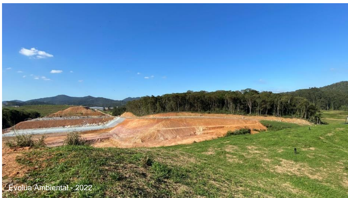
Figura 97 – Aterro Sanitário da Canhanduba
