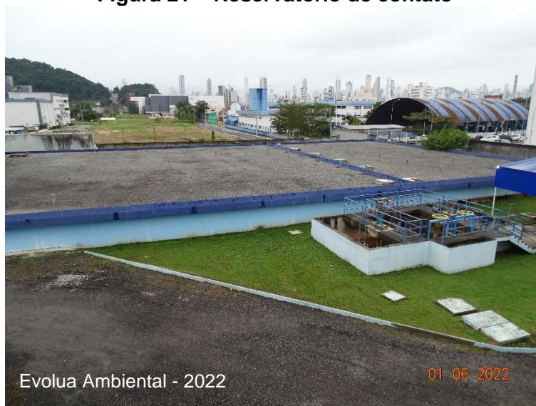
Figura 21 – Reservatório de contato
