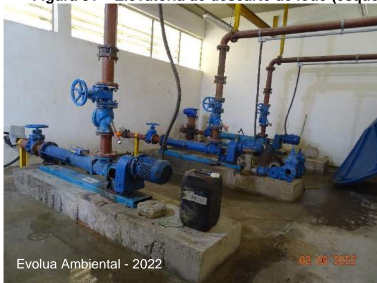
Figura 51 – Elevatória de descarte de lodo (esquerda) e de reciclo de lodo (direita)
