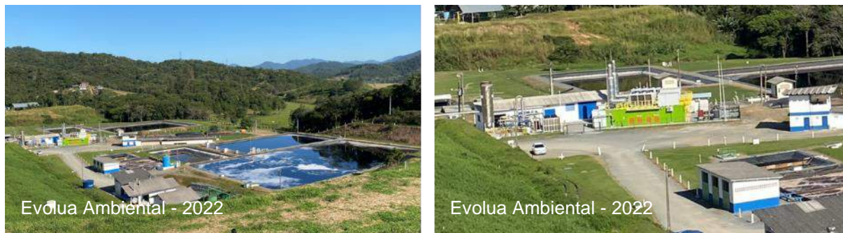
Figura 98 – Unidades de tratamento de efluentes líquidos e gasosos do aterro sanitário
