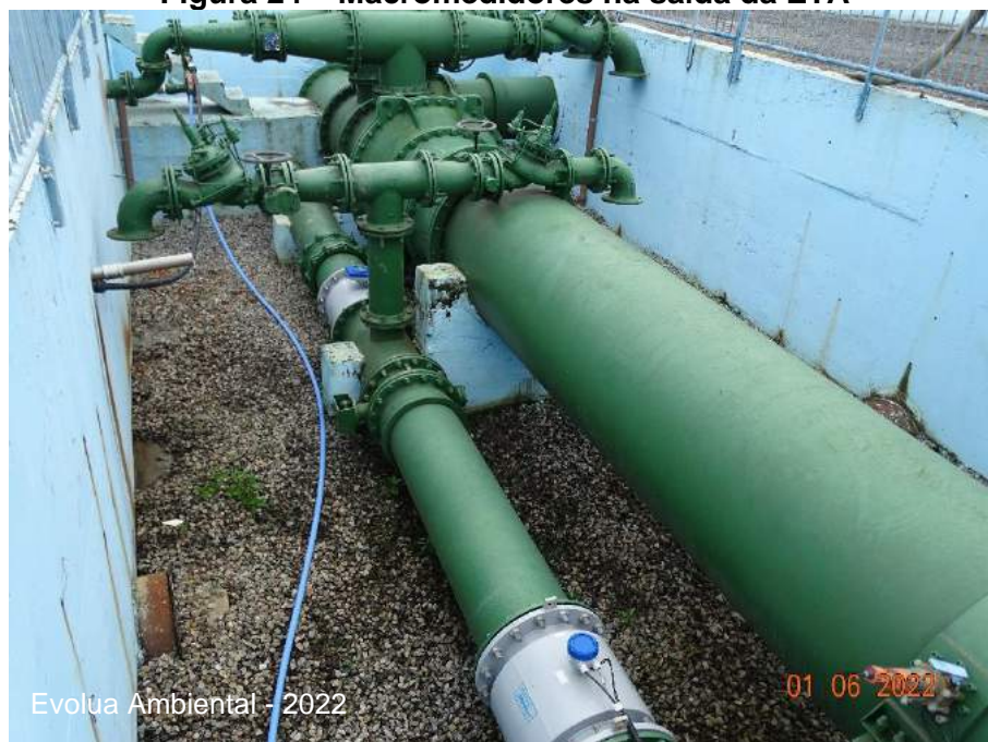
Figura 24 – Macromedidores na saída da ETA
