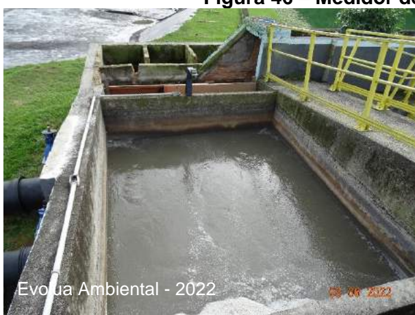
Figura 46 – Medidor de vazão de entrada da ETE
