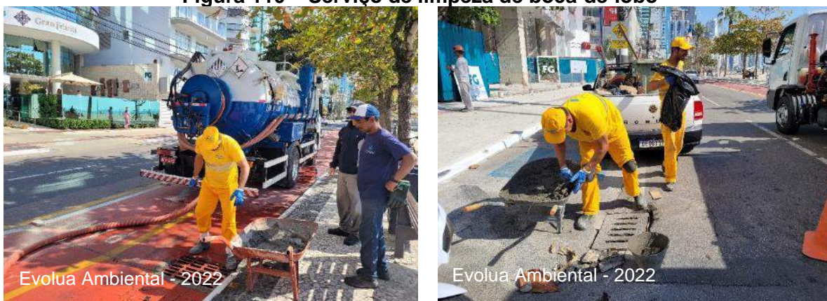
Figura 110 – Serviço de limpeza de boca-de-lobo
