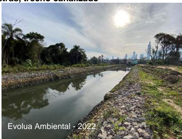
Figura 139 – Rio das Ostras, trecho canalizado
