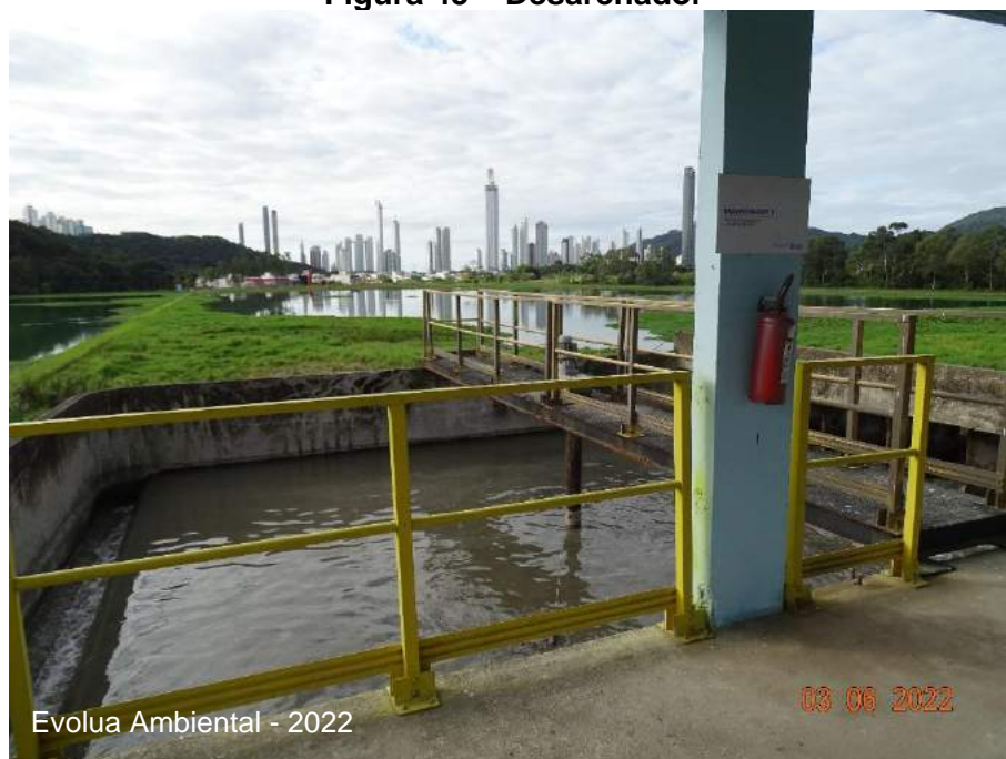
Figura 45 – Desarenador
