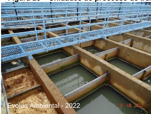
Figura 20 – Unidades do processo de tratamento (floculadores, decantadores e filtros)
