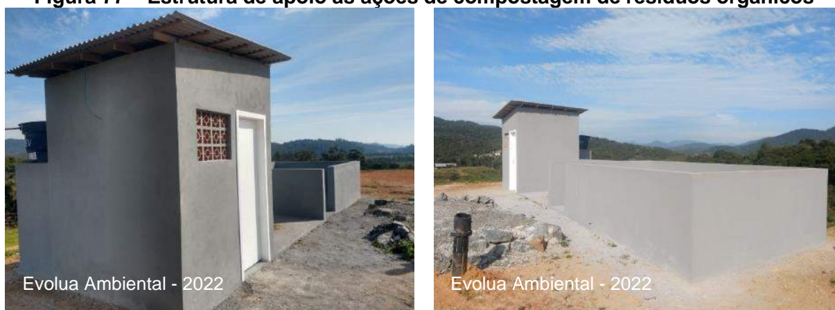
Figura 77 – Estrutura de apoio às ações de compostagem de resíduos orgânicos
