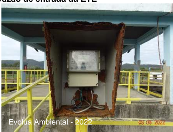
Figura 46 – Medidor de vazão de entrada da ETE
