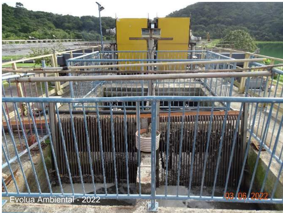
Figura 43 – Gradeamento.
