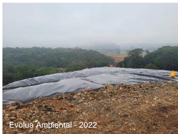
Figura 100 – Cobertura de maciço com lona de PEAD
