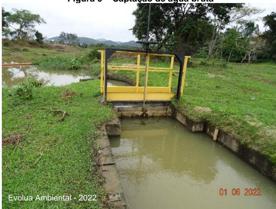
Figura 9 – Captação de água bruta
