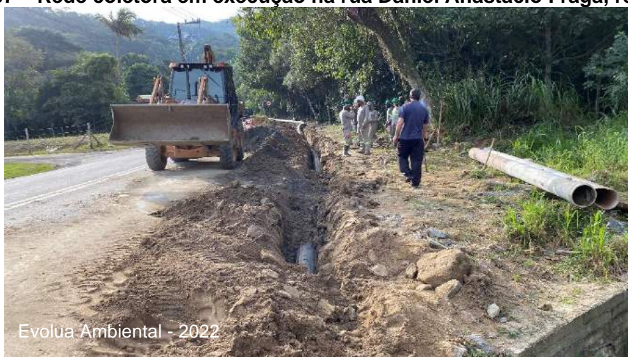
Figura 57 – Rede coletora em execução na rua Daniel Anastácio Fraga, região sul.
