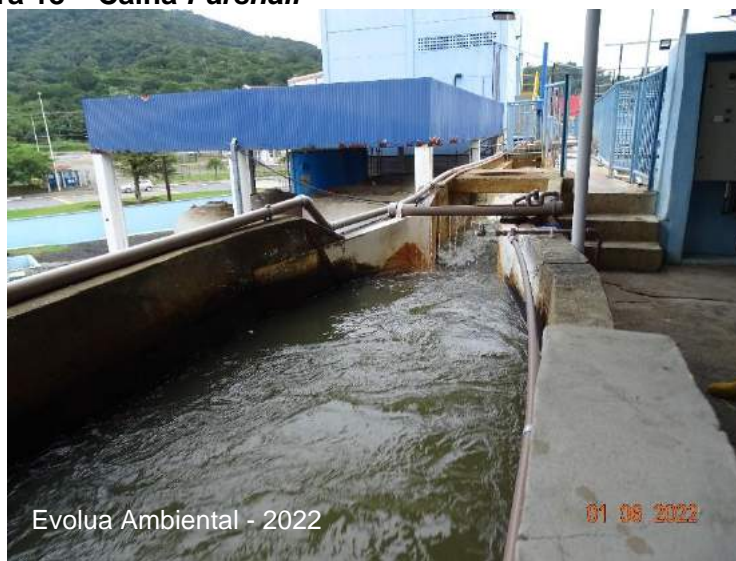
Figura 18 – Calha Parshall
