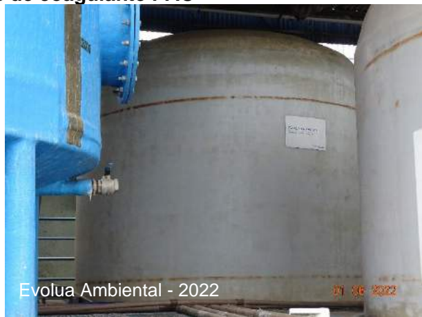
Figura 19 – Tanques de coagulante PAC
