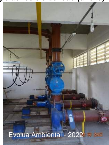
Figura 51 – Elevatória de descarte de lodo (esquerda) e de reciclo de lodo (direita)
