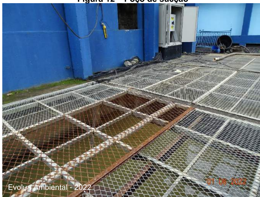
Figura 12 – Poço de sucção
