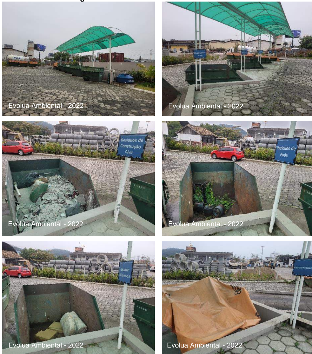
Figura 91 – Baias de recebimento dos resíduos
