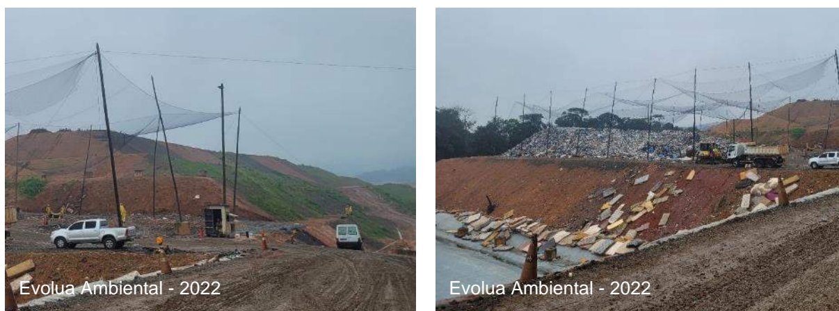
Figura 99 – Estabilização lateral dos maciços de resíduos sólidos
