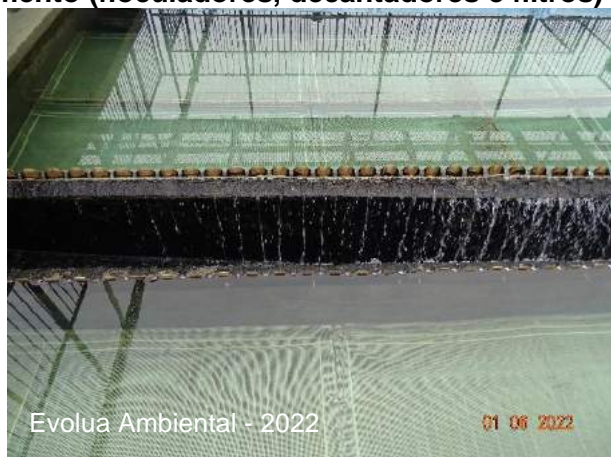
Figura 20 – Unidades do processo de tratamento (floculadores, decantadores e filtros)
