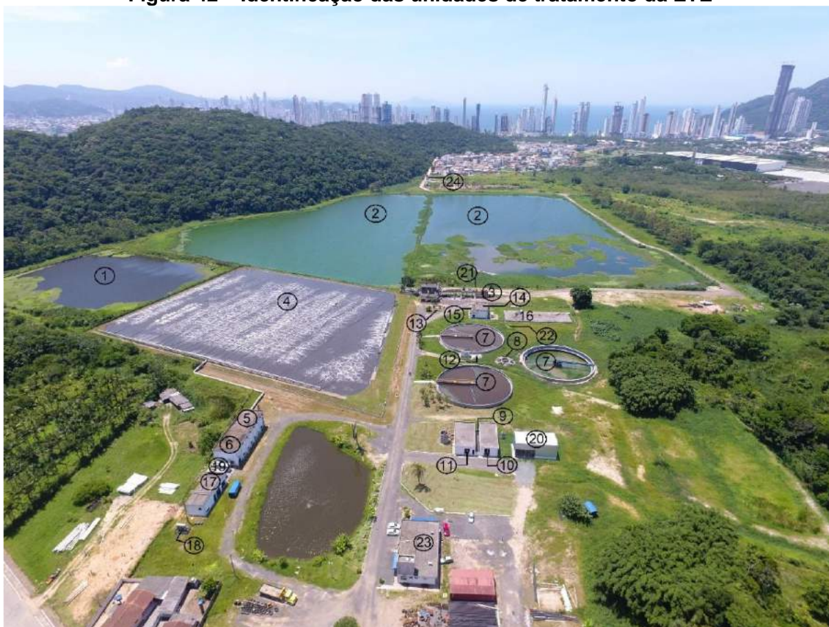
Figura 42 – Identificação das unidades de tratamento da ETE
