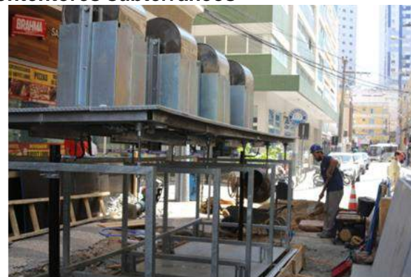
Figura 74 – Sistema de contentores subterrâneos
