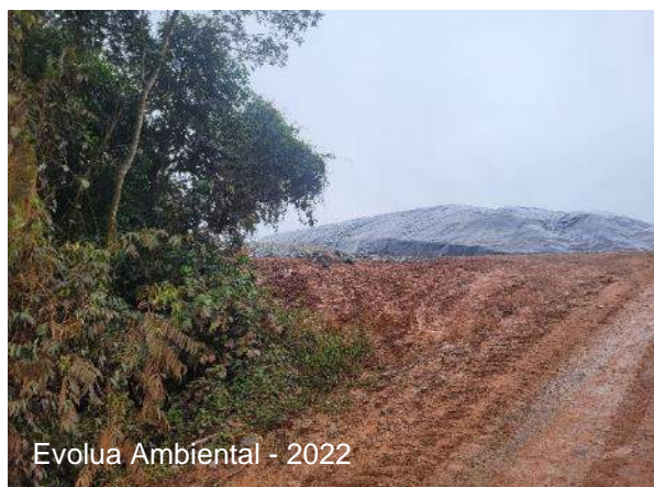
Figura 100 – Cobertura de maciço com lona de PEAD
