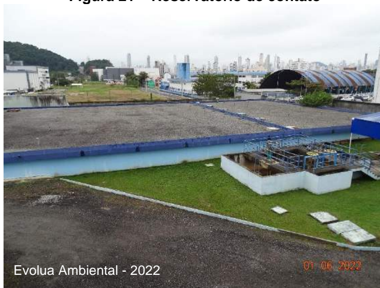
Figura 21 – Reservatório de contato
