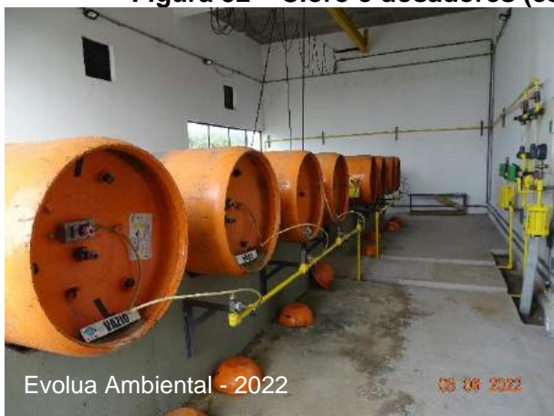
Figura 52 – Cloro e dosadores (esquerda) e tanque de contato (direita)
