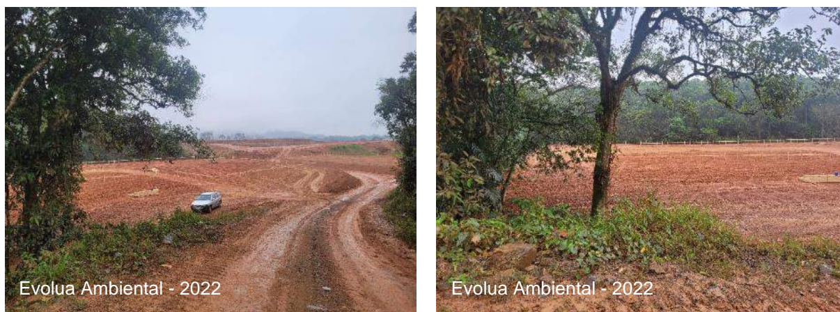
Figura 94 – CVM – terreno terraplanado
