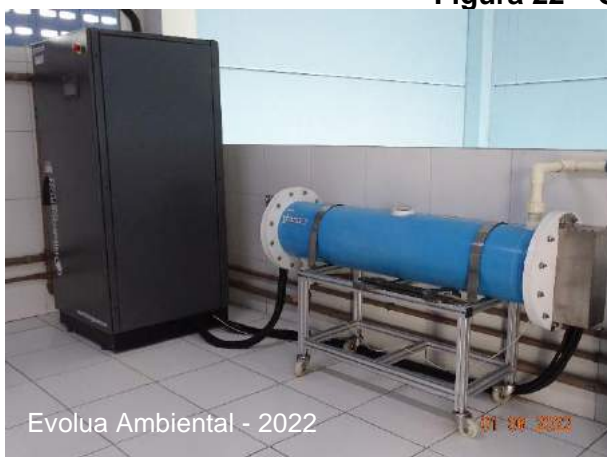
Figura 22 – Gerador de cloro
